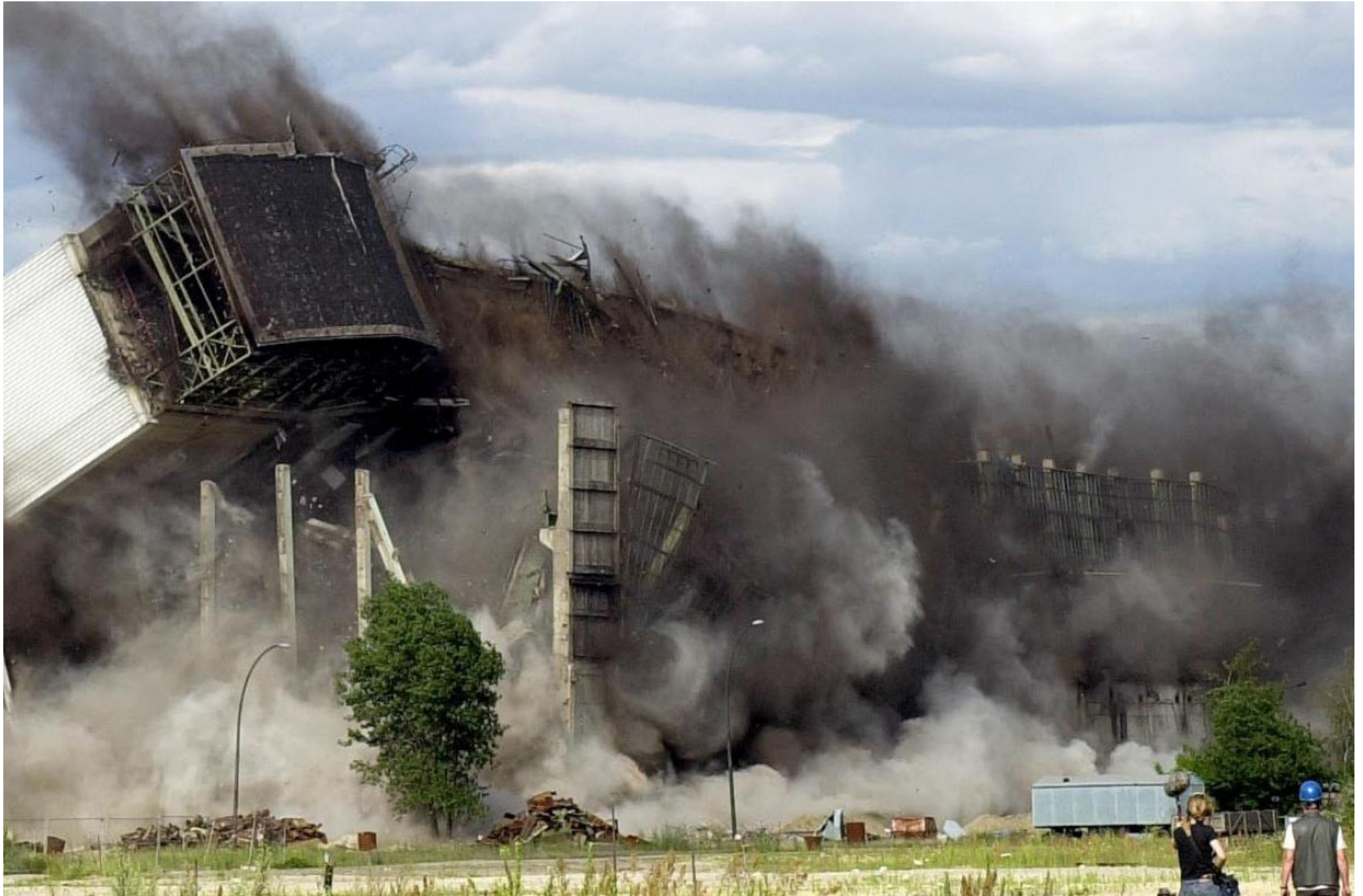
Sprengung Kraftwerk „Schwarze Pumpe“ West, 2001
