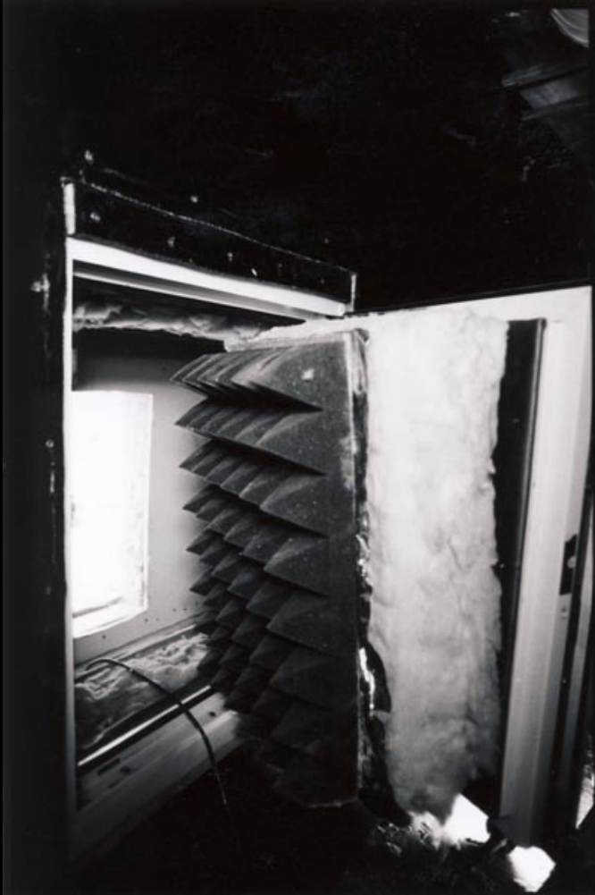
Abb. 3: Schallgedämmtes Fenster im Keller des Haus u r
