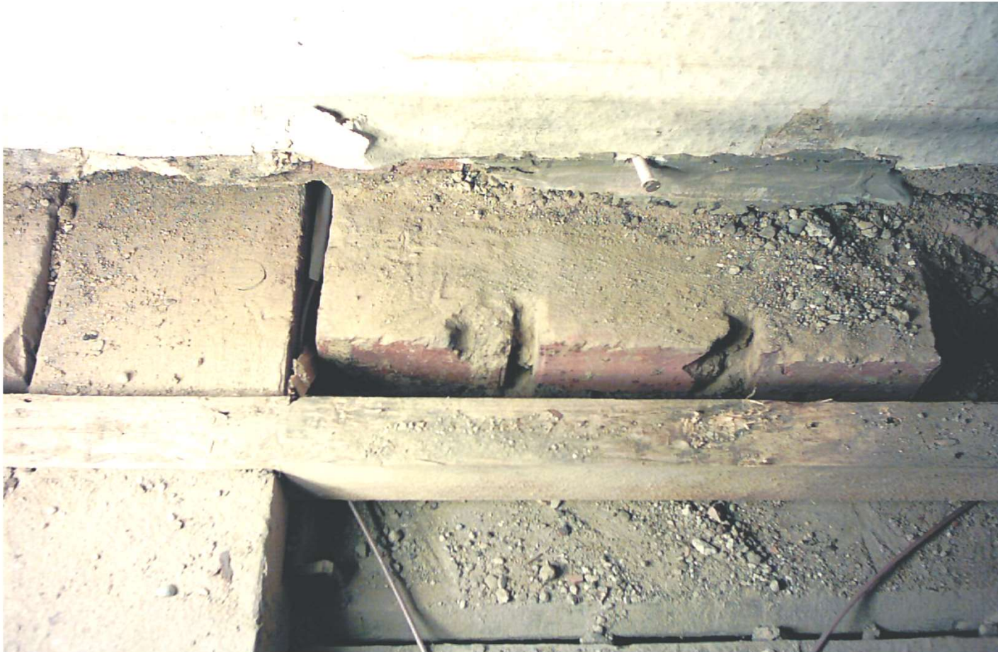
Messfühlereinbau Außenwand
