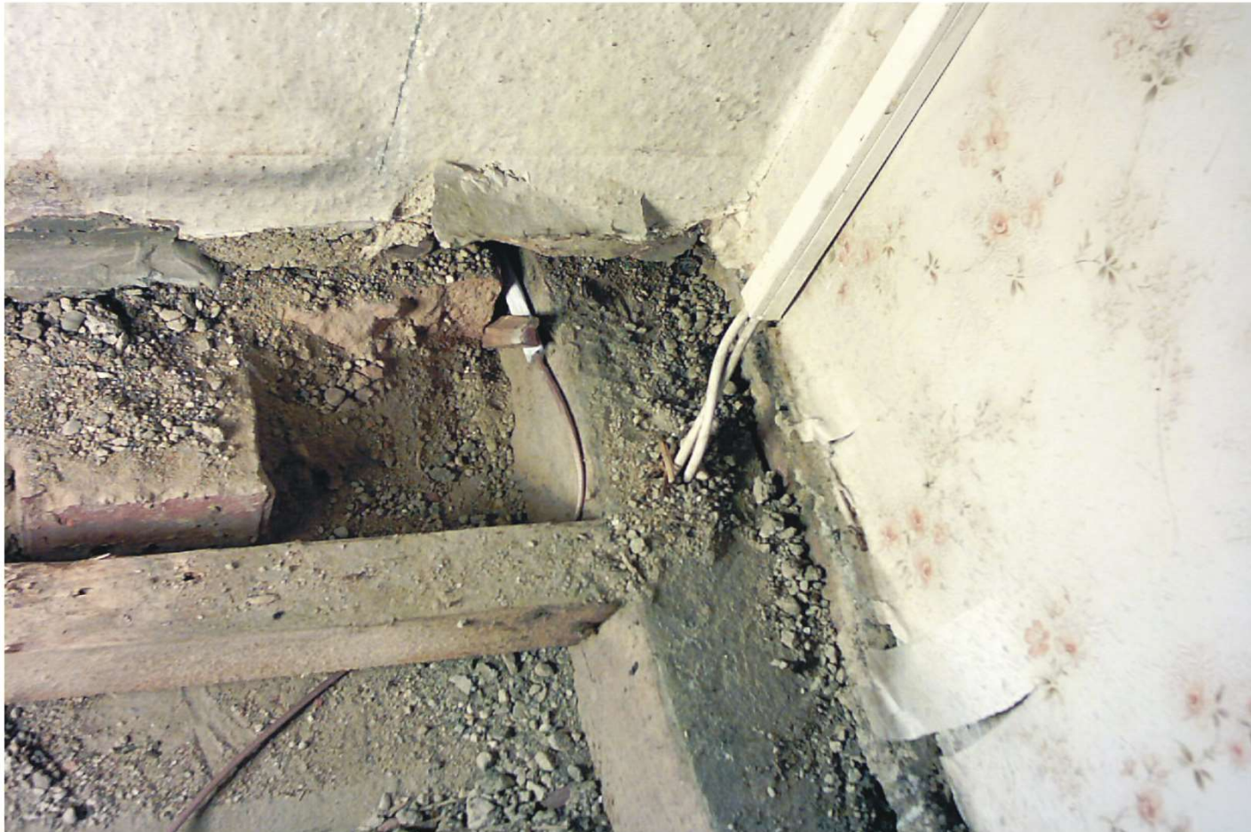
Messfühlereinbau Außenwand
