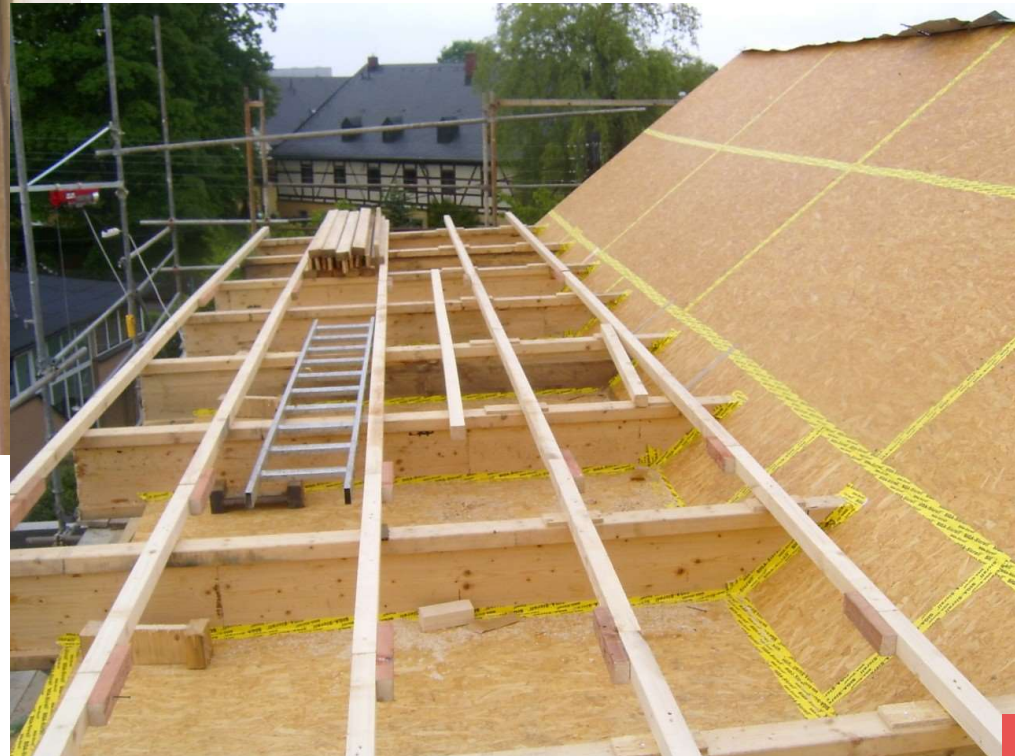
Neubau Dachgaube
