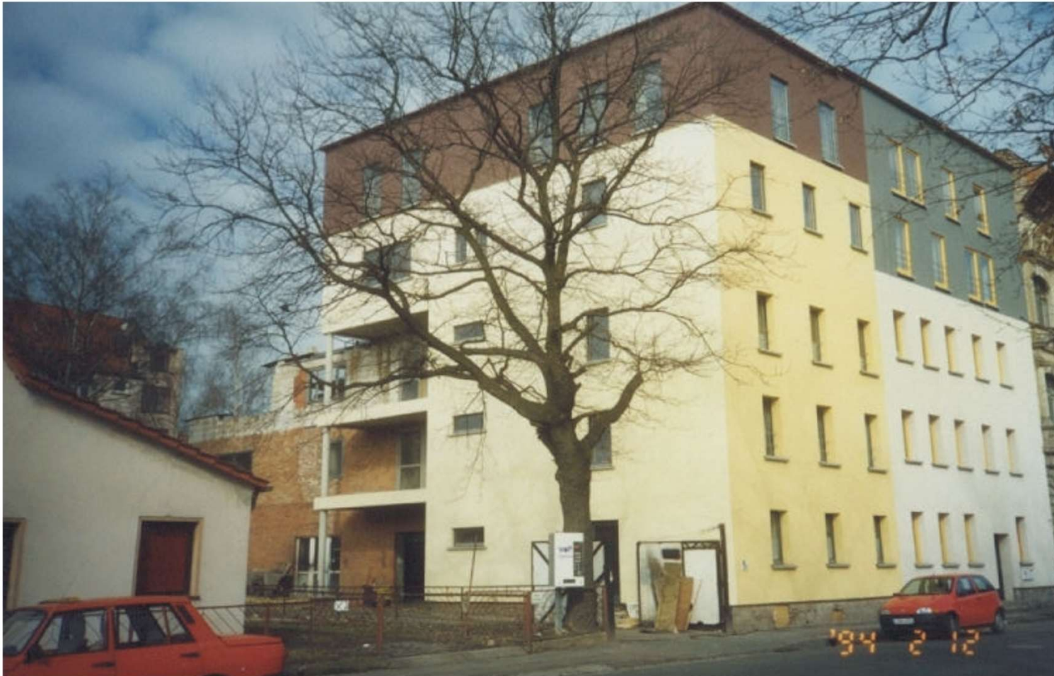
2005 Leipzig: Altbausanierung zum Passivhaus, Aufstockung
