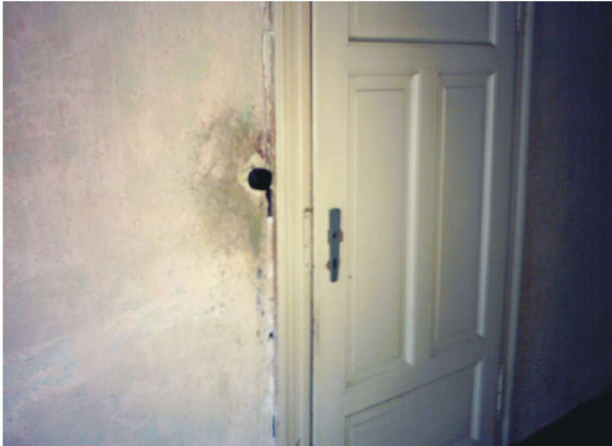
Mangelnde Luftdichtheit
