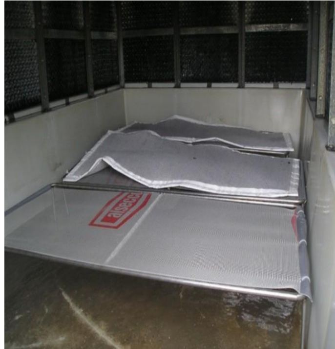
65 m 3 , die Kühlwasserkreislauf (ab Aug. 2007)
