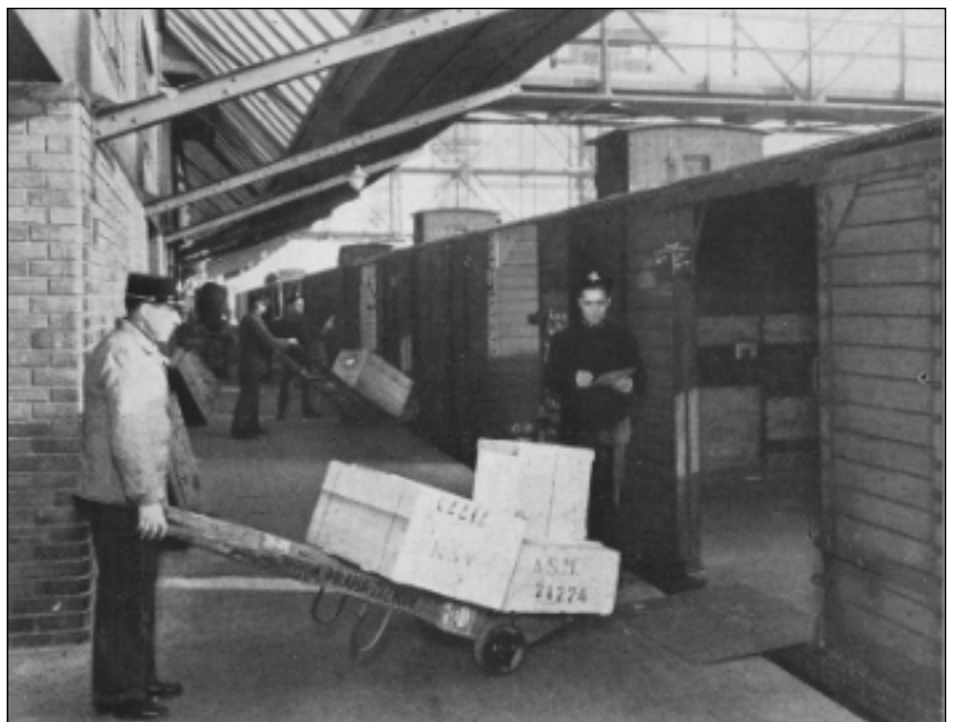
Abb. 24: Güterbahnhof Žižkov, historische Aufnahme bei der Warenentladung an den Bahnsteigen, © Fotografie aus der Zeitschrift „Šťastnou cestou“, via CAMP / IPR, Stadt Prag
