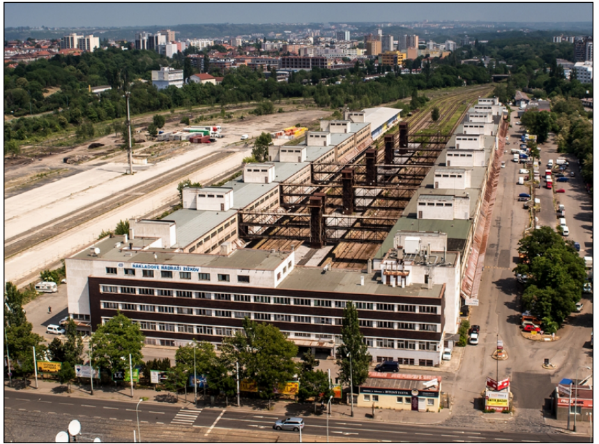
Abb. 20: Güterbahnhof Žižkov, Hauptgebäude mit seitlichen Etagenlagerhallen (links: Anlieferung, rechts Ausgabe, Laderampen an der Straße). Innenhof mit zwei Gleisen und Entlade-Aufzügen, © Stadt Prag / IPR
