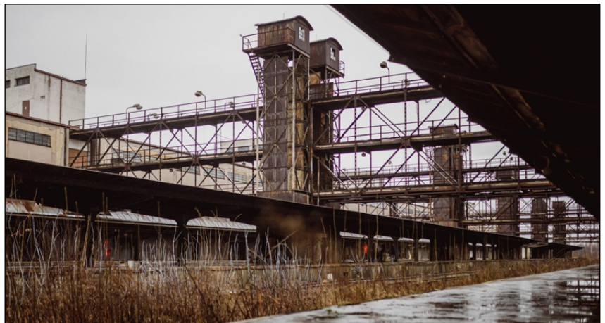
Abb. 18: Güterbahnhof Žižkov, Blick von den Bahnsteigen vor den seitlichen Lagerhallen auf die Aufzugstürme und Brücken, © Stadt Prag / IPR
