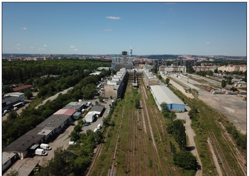
Abb. 01: Blick von Osten in Richtung Westen auf das Gelände des Güterbahnhofs Žižkov, © Stadt Prag/IPR
