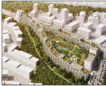
Abb. 53 + 54: Neubauvorhaben am Güterbahnhof Zizkov im Nordosten (links) bzw. Osten des Bahnhofgebäudes, © Stadt Prag / IPR
