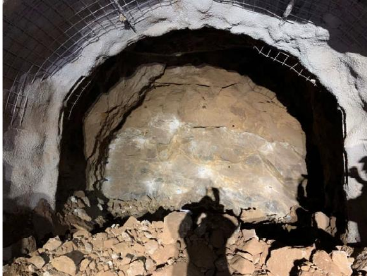
Abschlag 82 nach Sprengung
