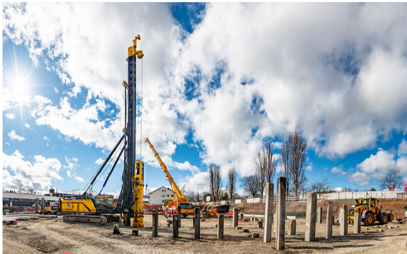
Gründungen und Fundamente [Aarsleff]
