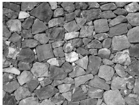
Bild NA.L.14 — Beispiel für Bruchstein-Zyklopenmauerwerk
