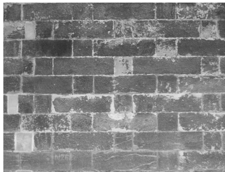
Bild NA.L.20 — Beispiel für Quadermauerwerk
