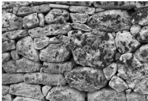
Bild NA.L.13 — Beispiel für Findlingsmauerwerk
