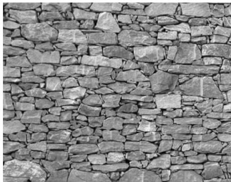
Bild NA.L.16 — Beispiel für Bruchstein-Schichtenmauerwerk
