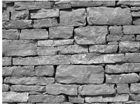
Bild NA.L.17 — Beispiel für Schichtenmauerwerk Güteklasse N2
