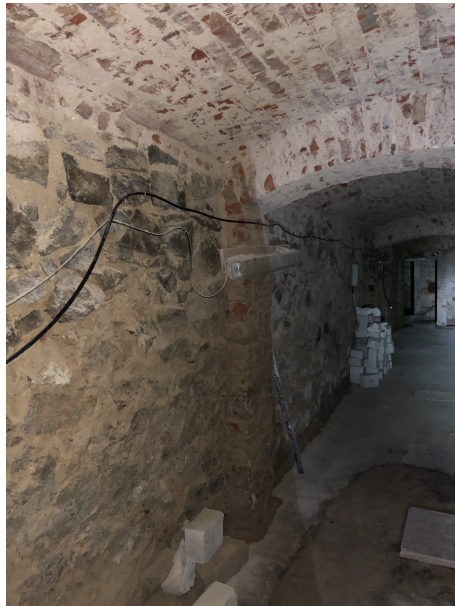
Abbildung 3: Ansicht der Kellerinnenwand aus Granitsteinen und Kalkmörtel (M 1)
