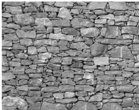
Bild NA.L.16 — Beispiel für Bruchstein-Schichtenmauerwerk
