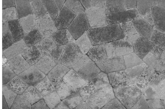
Bild NA.L.15 — Beispiel für Zyklopenmauerwerk
