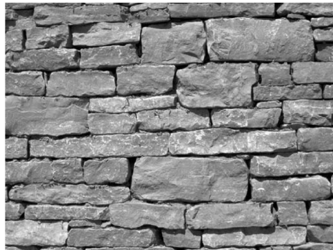
Bild NA.L.17 — Beispiel für Schichtenmauerwerk Güteklasse N2
