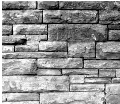
Bild NA.L.18 — Beispiel für unregelmäßiges Schichtenmauerwerk Güteklasse N3
