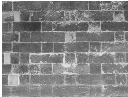
Bild NA.L.20 — Beispiel für Quadermauerwerk
