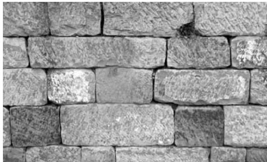
Bild NA.L.19 — Beispiel für regelmäßiges Schichtenmauerwerk Güteklasse N3
