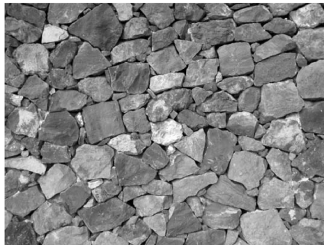
Bild NA.L.14 — Beispiel für Bruchstein-Zyklopenmauerwerk
