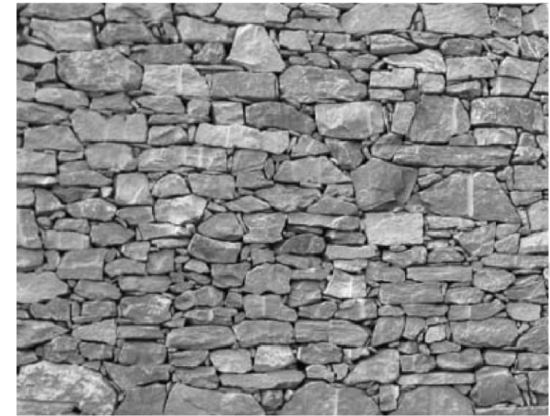
Bild NA.L.4 — Beispiel für Bruchstein-Schichtenmauerwerk
