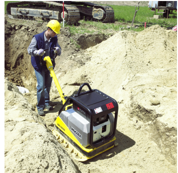
Bodenverdichtung und Bodenverbesserung [TREVI Geotechnik], [Wikipedia]
