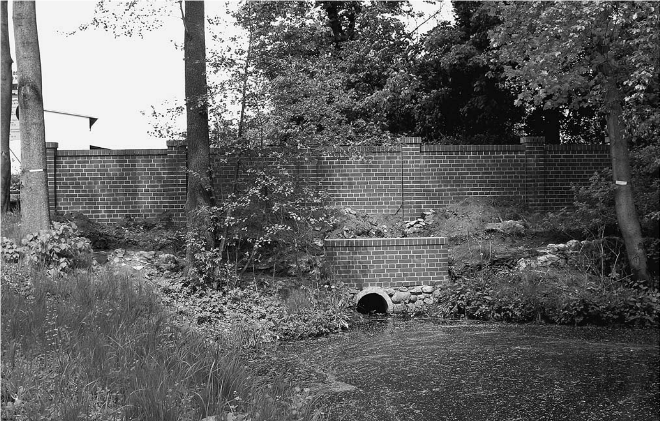
Abb. 14 Steinhöfel, Landkreis Oder-Spree, Schlosspark, Quellfassung, Zustand Juni 2002, Beispiel einer fotografischen Darstellung der Situation vor dem Beginn einer Baumaßnahme
