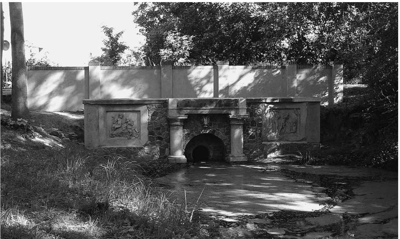
Abb. 15 Steinhöfel, Landkreis Oder-Spree, Schlosspark, Quellfassung, Zustand Juli 2004, Beispiel einer fotografischen Darstellung der gleichen Situation wie in Abb. 10 nach Beendigung der Baumaßnahme
