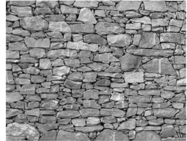
Bild NA.L.4 — Beispiel für Bruchstein-Schichtenmauerwerk
