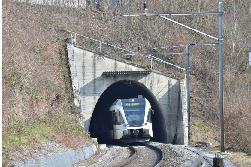
(b) Beispiel für einen vergleichsweise großzügigen Tunnelquerschnitt
