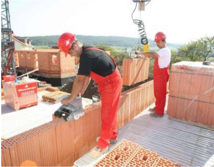
Abb.: Poroton-Planelemente-T500, d = 17,5 cm
