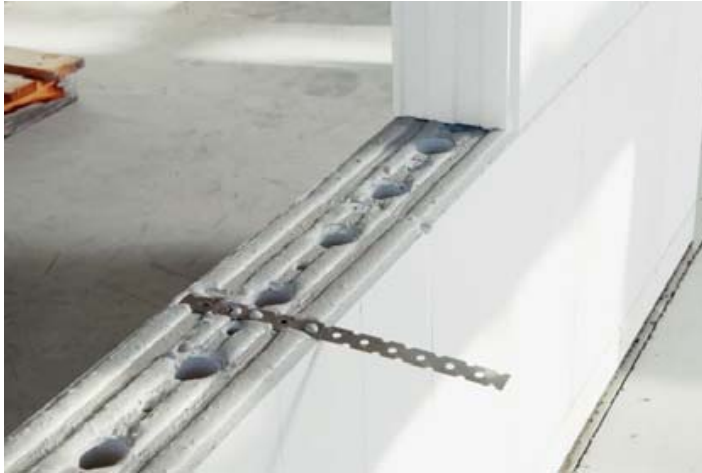
Abb.: Beim Aufmauern wird der Edelstahl-Flachanker im Mörtelbett eingelegt
