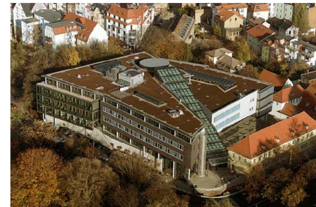
Der 2001 eröffnete Neubau der Thüringer Universitäts- und Landesbibliothek in Jena (Architekten: Heckmann, Kristel, Jung) mag als Antwort auf die Frage gelten, ob Bibliotheken im Zeitalter der Datennetze noch ein Gebäude brauchen. Das einschichtige Bibliothekssystem Jena, das über vier Mio. Medieneinheiten verfügt, besteht aus der Zentralbibliothek, drei größeren Teilbibliotheken und zahlreichen im Stadtgebiet verteilten Teil- und Zweigbibliotheken, deren Zahl schrittweise verringert werden soll. – Foto: P. Scheere, FSU Jena
