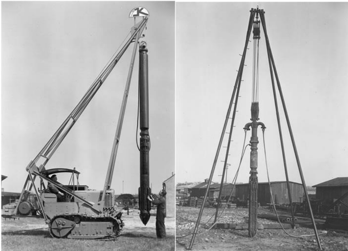
Abbildung 2 Rüttler an Vierbock aus dem Jahr 1956
