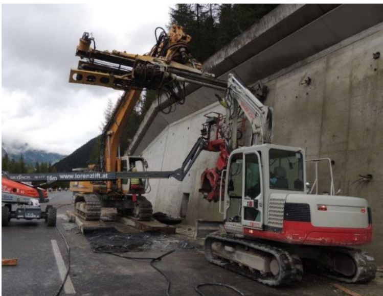
Abbildung 15 Bagger mit Anbaulafette im Einsatz
