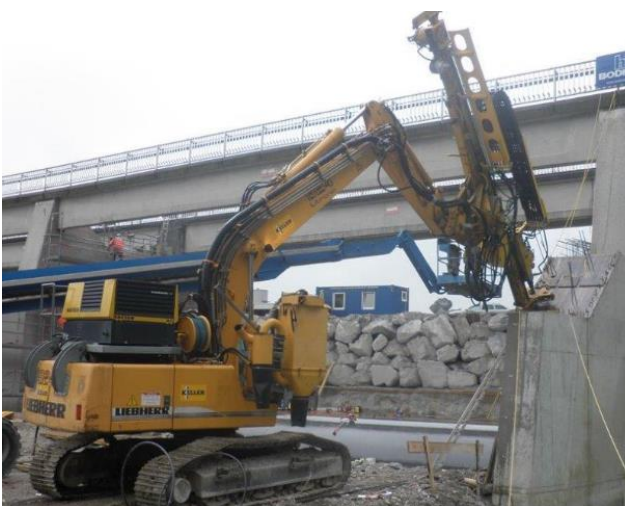
Abbildung 14 Bagger mit Anbaulafette im Einsatz
