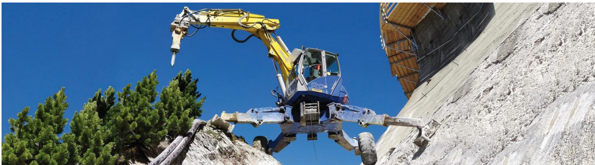
Abbildung 13 Schreitbagger im Einsatz
