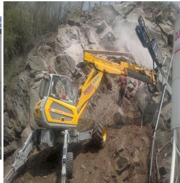
Abbildung 16 Schreitbagger mit Anbaulafette
