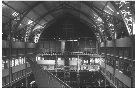
Abb. 4: Der Eisenskelettbau des Pitt-Rivers-Museums (Foto: Nikolai Delvendahl)
