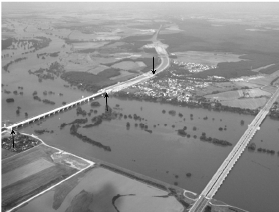
Abbildung 1: Foto der übergetretenen Elbe bei Magdeburg. Das Foto wird als Ergebnis einer Zentralprojektion angenommen.
