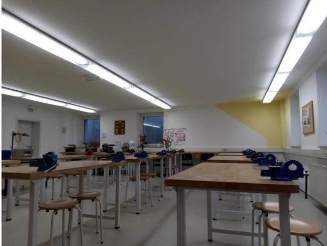
Abb. 1: deplatzierte Lichtleisten
