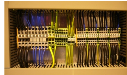
Fingersichere Verdrahtung
