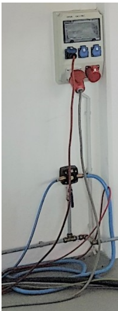
Abb. 3.4 Anschlüsse einer Maschinenanlage an die Medienversorgung
