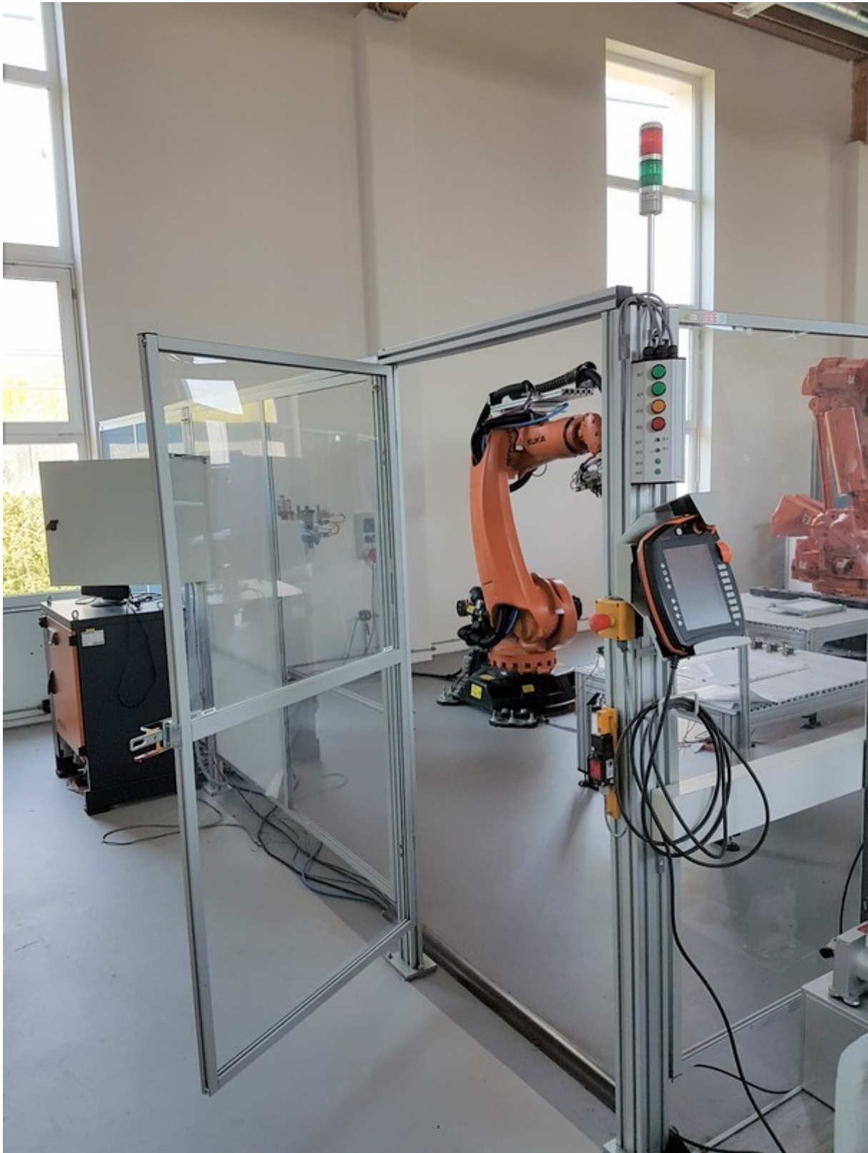
Abb. 7.3 Trennende Schutzeinrichtungen und Not-Halt-Geräte am Industrieroboter
