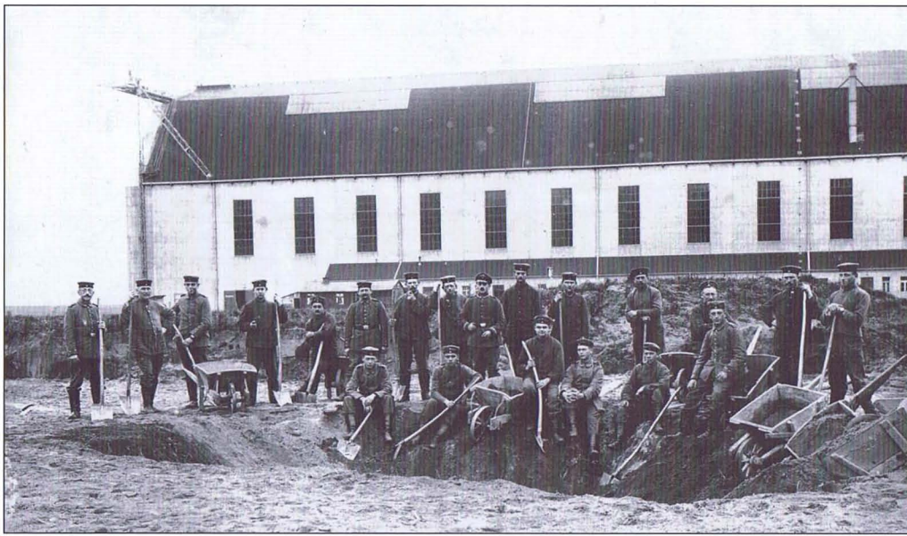
Das Kriegsministerium errichtete 1915 in eigener Regie eine Militärflughalle, die nach dem Ersten Weltkrieg aufgrund des Versailler Friedensvertrages bis zum 30. September 1921 zerstört werden musste. Die große Halle für Zeppelin-Luftschiffe wurde ungefähr 1921 abgebrochen und nach Wilthen (Firma Hünlich) umgesetzt. Diese Halle dient der Wilthener Weinbrennerei als Lagerraum.
