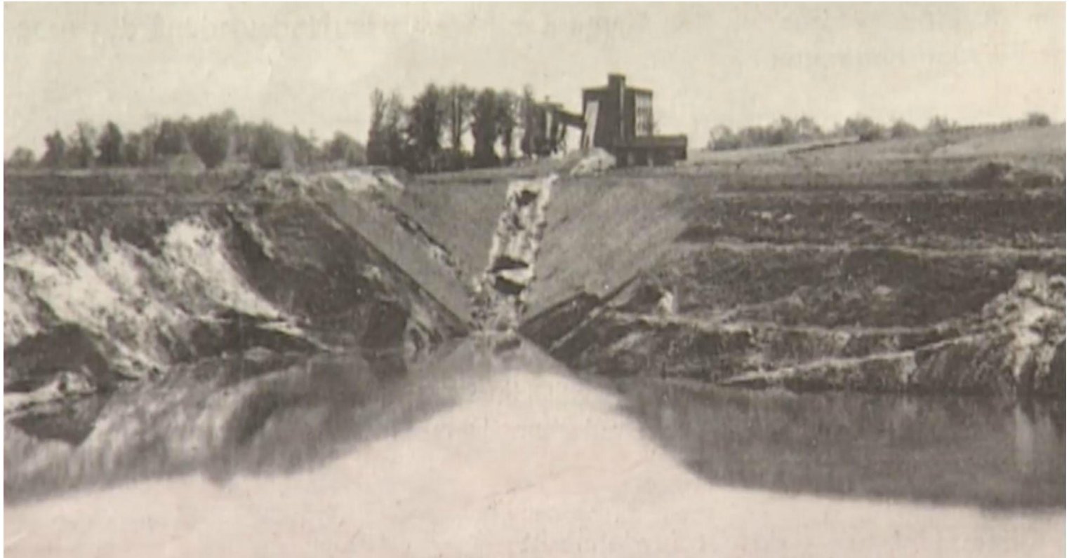
Abgesoffener Tagebau Berzdorf, 1945
