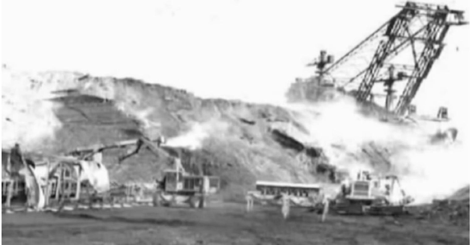
Laufende Steuerung des Gewinnungsbetriebs zur Beherrschung des Rutschungsablaufs
