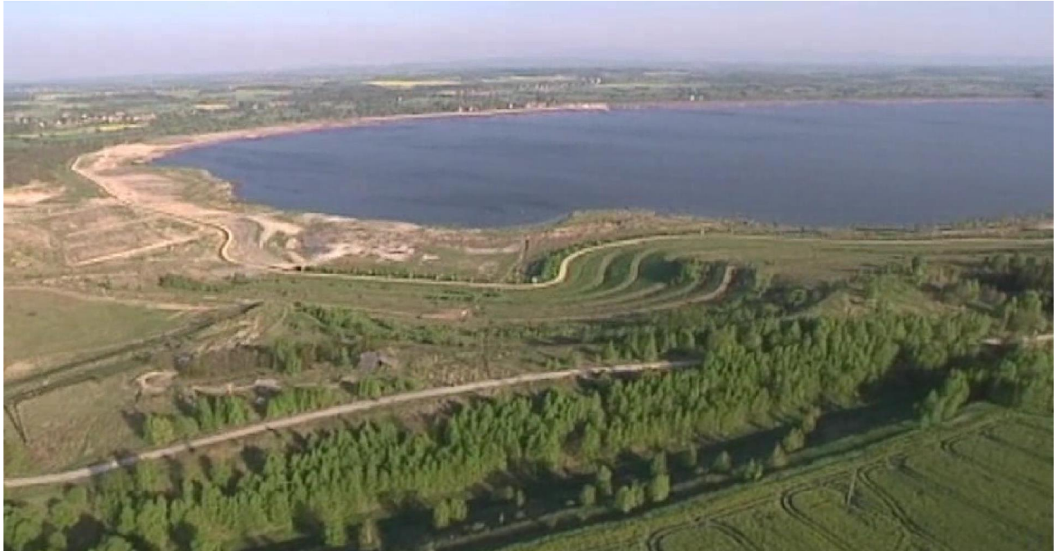
Nordböschung, Camping Platz, Stützkippe 4
