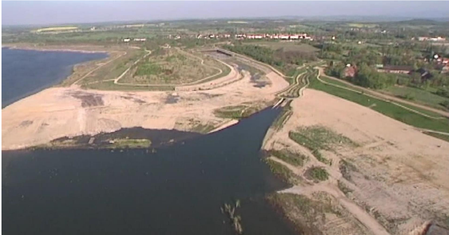
Hafenbereich und Pließnitz-Zulauf
