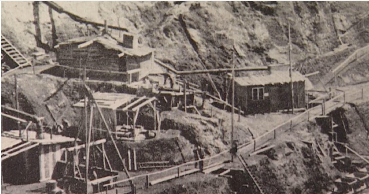
1. Wasserhaltungsanlage Tagebau Berzdorf, 1946
