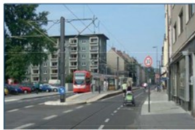
Mittelbahnsteig für Niederflurfahrzeuge mit straßenbündigem Bahnkörper ohne Signalisierung (EAÖ 2013)
