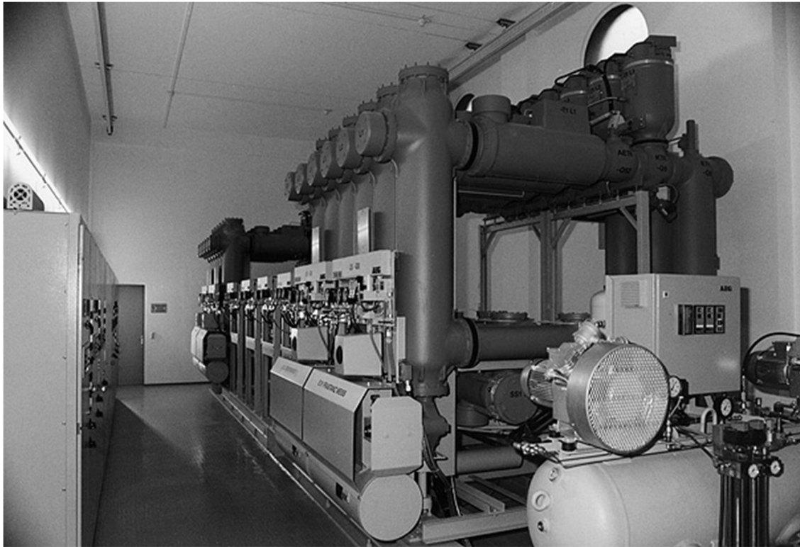
SF 6 -Innenraumschaltanlage
