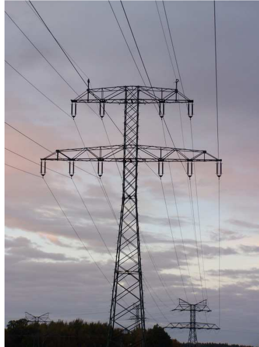
Masten mit unterschiedlichen Systemspannungen
