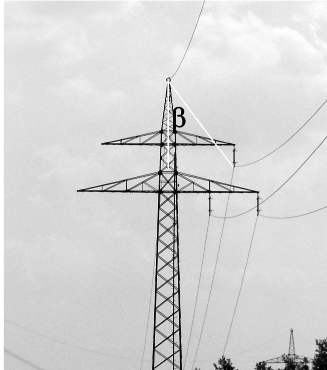
Einbauwinkel \beta an einem Freileitungsmast
