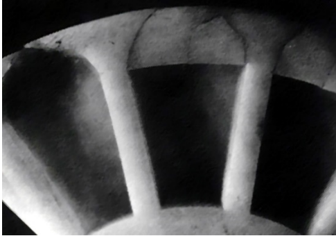
Rissverlauf an einer Stegrolle
