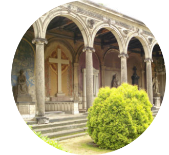
Arkadengange der Eingangsanlage
