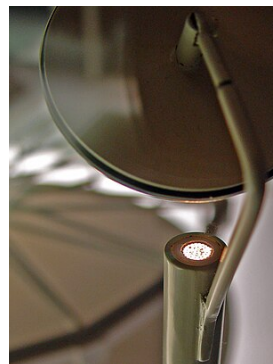
Indirekte Beleuchtung mit optischen Fasern
