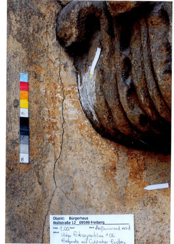
Abb. 3 Detail von Abb.2 Die Erstfassung auf dem Erstputz von 1914
